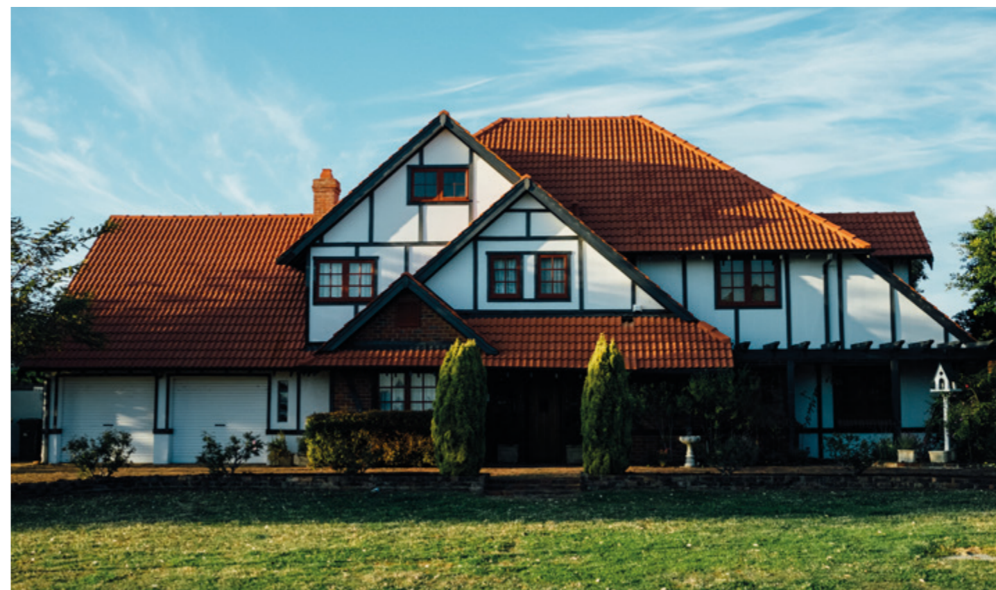
Běžný rodinný dům nepodléhá kolaudačnímu řízení, pokud je stavbou pro bydlení, ve které více než polovina podlahové plochy odpovídá požadavkům na trvalé rodinné bydlení a je k tomuto účelu určena. Foto redakce
